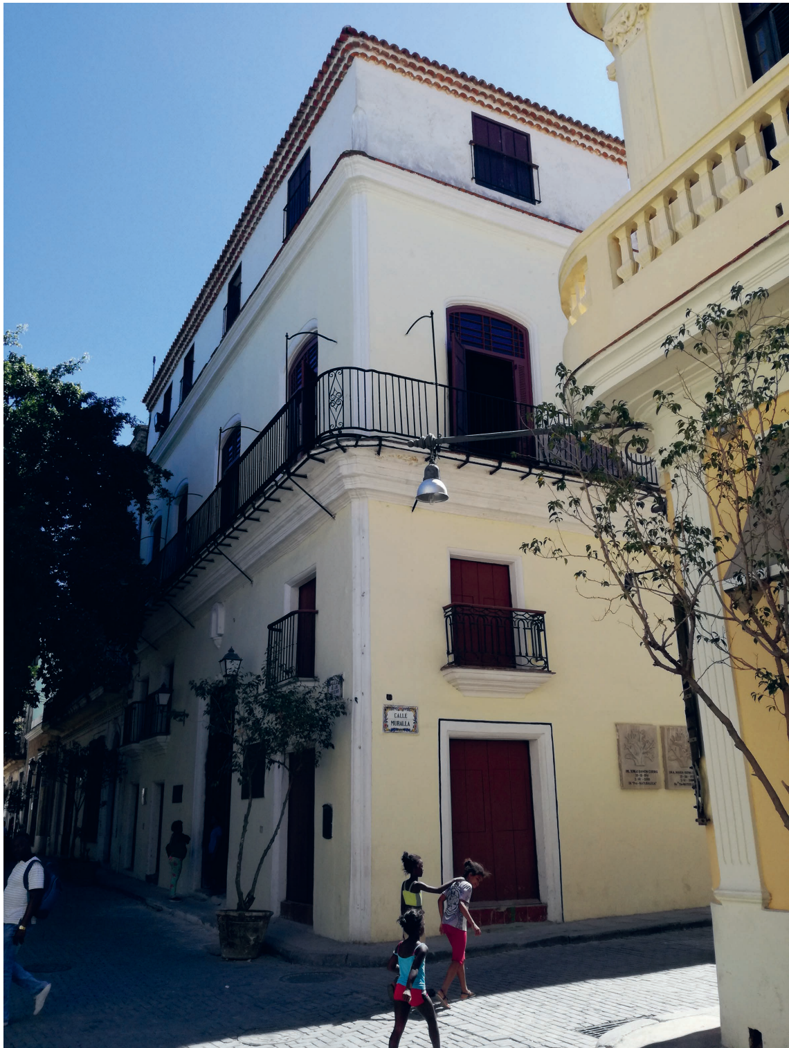
Casa Humboldt in der Calle Oficios, Ecke Calle Muralla, La Habana Vieja. © Peter Korneffel, 2018
